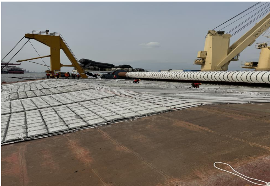
图 2，施工船采用铺排进行防护
