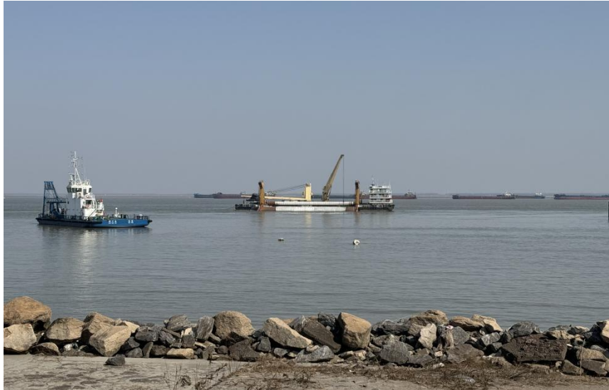
图 1，施工区域，中间为施工船
